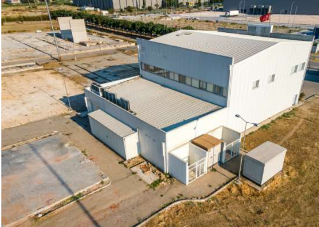
Taşınmazın Görünümleri (İdari bina)
