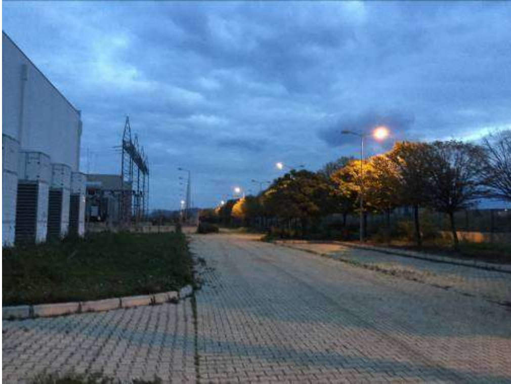
Tesisin Görünümleri (Arşiv)
