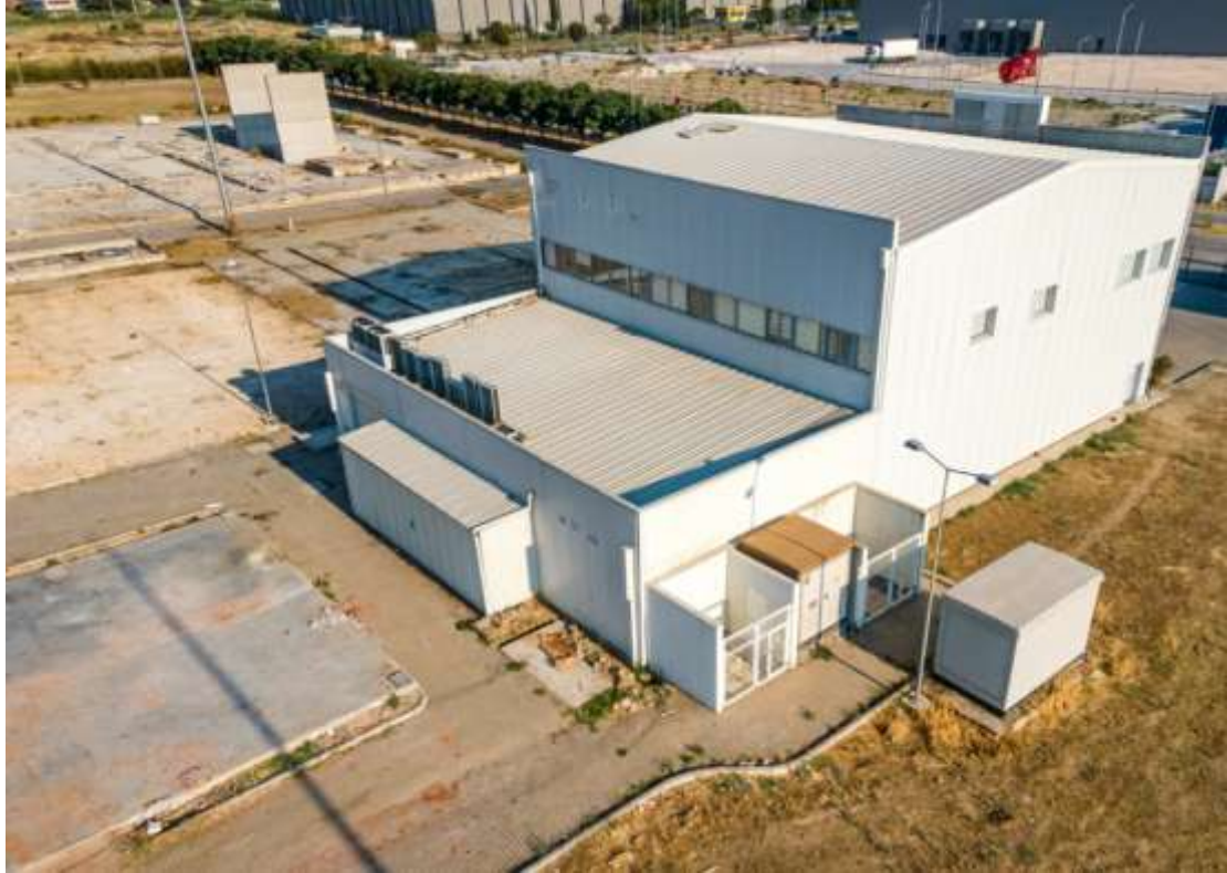
Taşınmazın Görünümleri (İdari bina)
