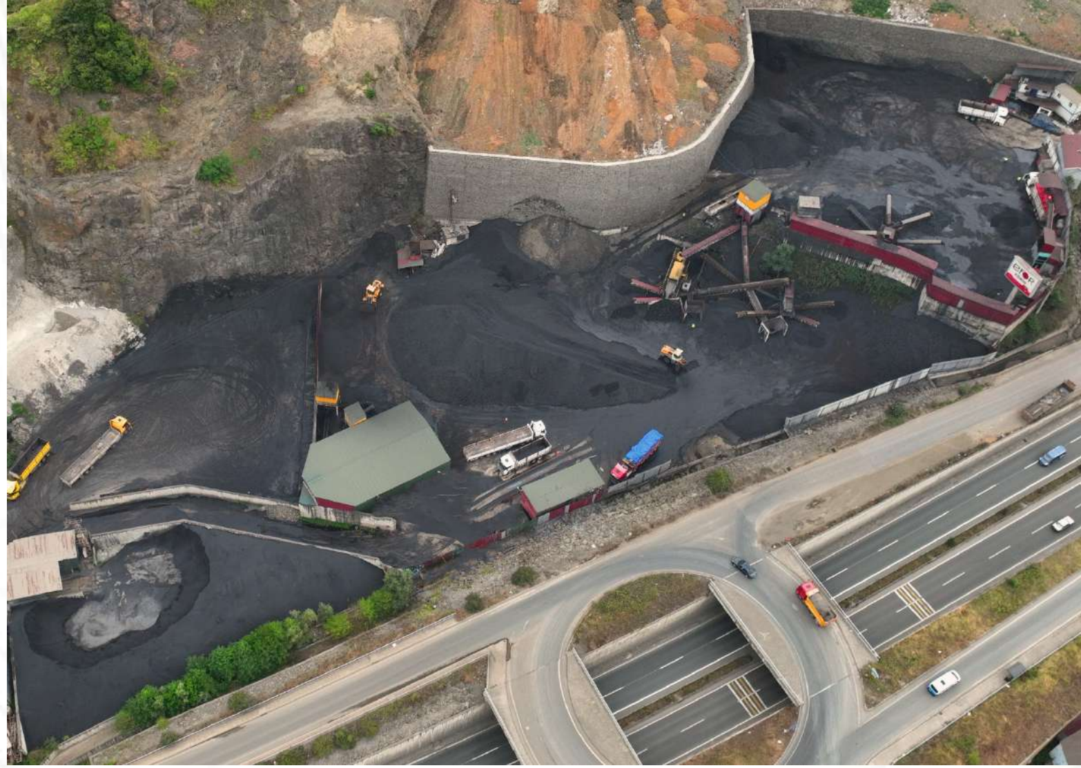
Trabzon Kömür Tesisi: Tesis Alanı: 12.000 m 2 Tesis Kapasite: 666 Ton/Gün
