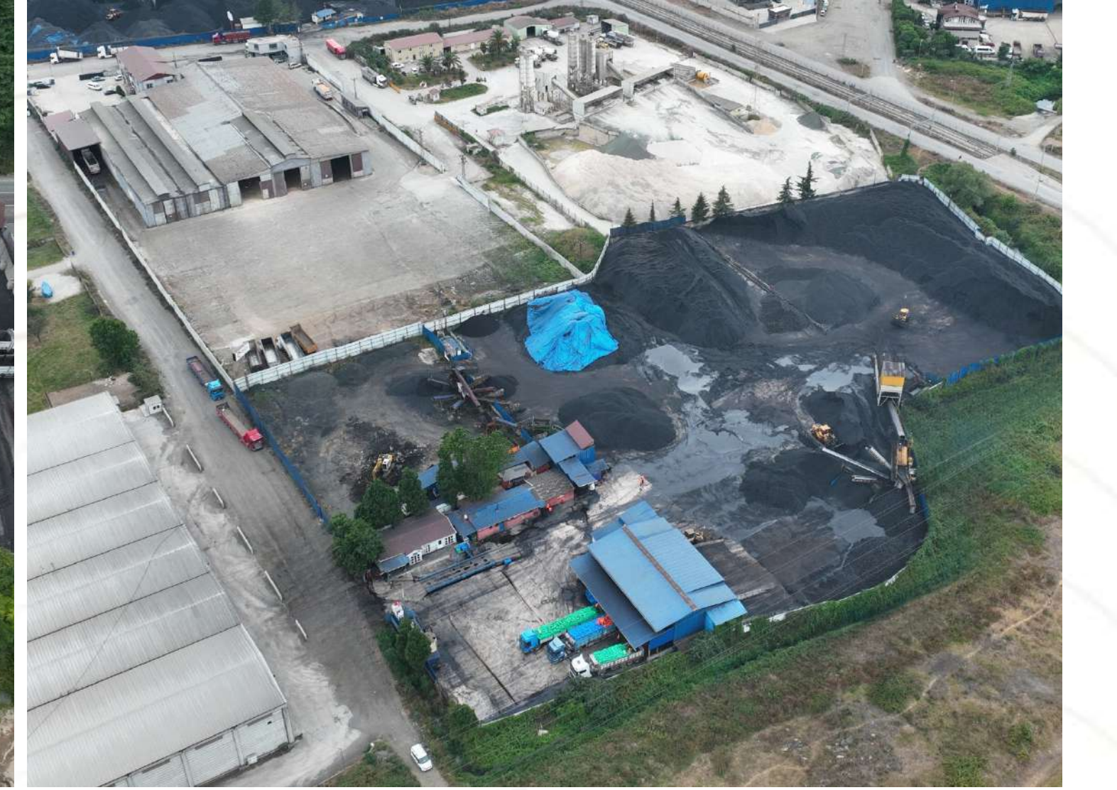
Samsun Kömür tesisi: Tesis Alanı: 12.380 m 2 Tesis Kapasite: 512 Ton/Gün
