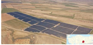
Elbistan GES (Kahramanmaraş)
