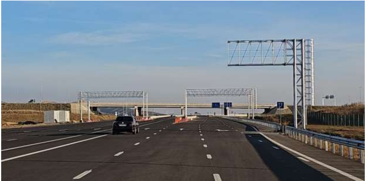
Ahmetbeyli – Fuzuli – Şuşa Otoyolu Projesi
