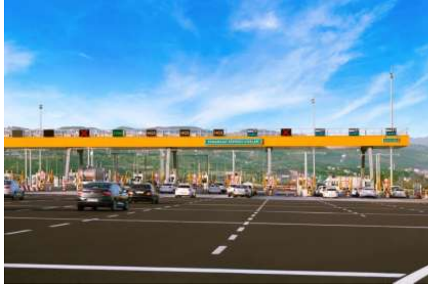
Gişe Tipi Otoyol Ücret Toplama Sistemleri
