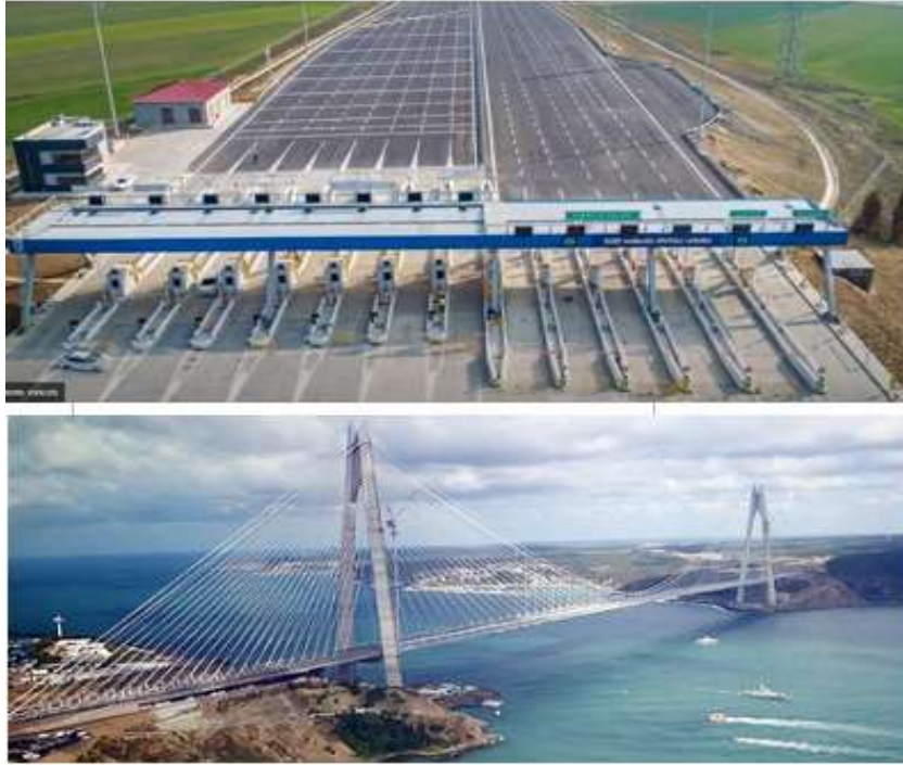
Kuzey Marmara Otoyolu Projesi
